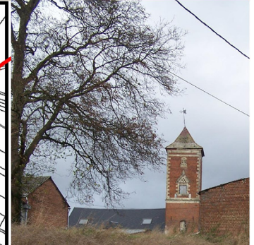
Rue de la Folie: Corps de ferme à cour carrée et pigeonnier
