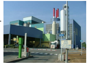
Usine d'incinération de Saint Saulve
