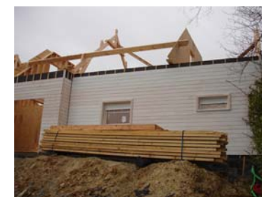
Maison à ossature bois en construction à Vertigneul
